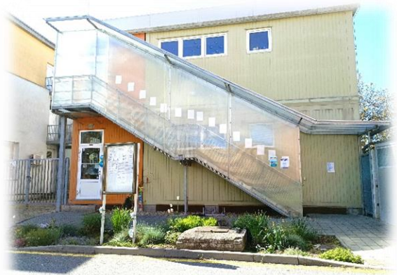
Foto 2 – Kontejnerová přístavba MŠ
